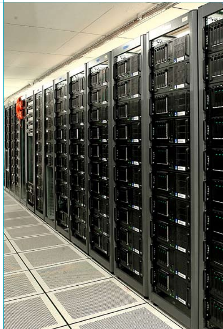
Forskning som genererer store datamengder krever også store regneressurser. Her fra kontrollrommet på CERN. Foto: CERN
